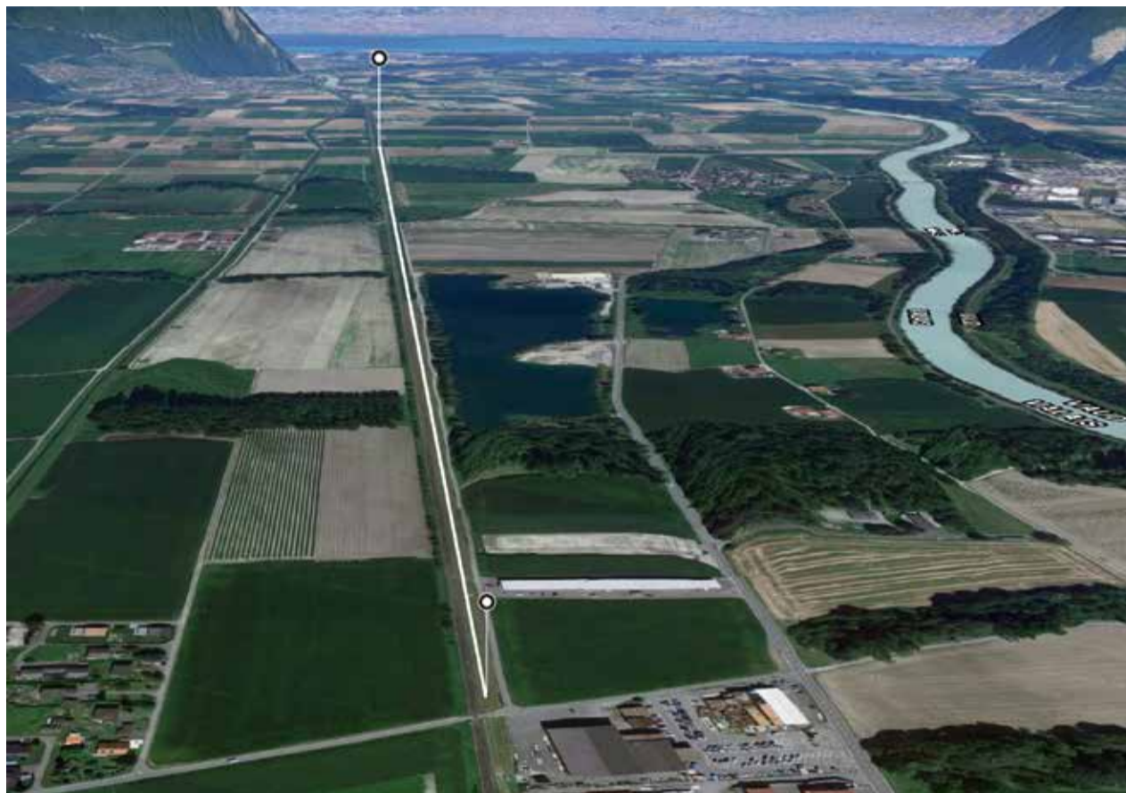
Le tube, d'une longueur de 3 kilomètres et d'un diamètre de 2 mètres, longera les rails de chemin de fer entre la zone industrielle de Collombey-Muraz et la gare de Vionnaz. (DR)
